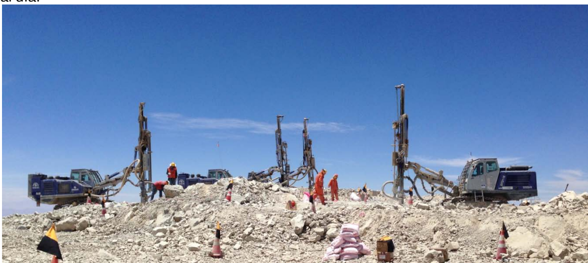
Imagen 2: Perforación en Plataforma – Obra Cerro Armazones
